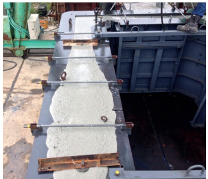
As figuras 1 e 2 mostram a forma para a produção da seção transversal estrutural de 12,3 t de peso do concreto.
